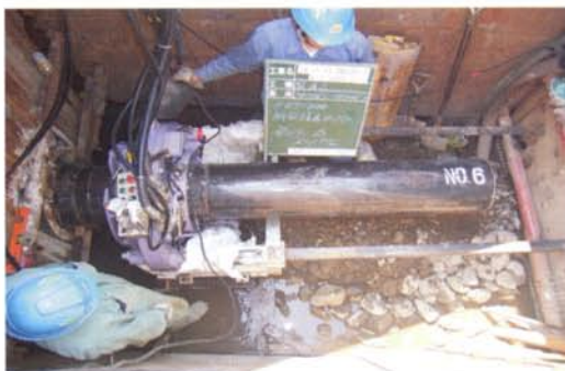
φ2500立坑よりφ350×1.5m管推進状況
