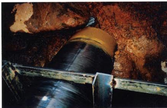
鋼管径φ350 転石削進状況
