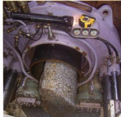
岩盤削進状況
