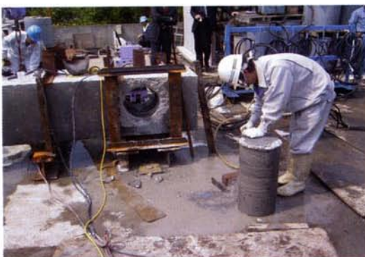
コンクリートブロック 削進完了
