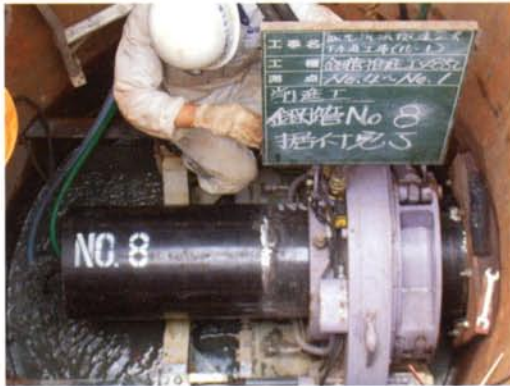
φ1500立坑よりφ350×0.6m管推進状況
