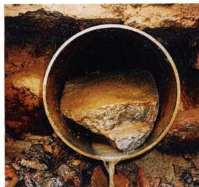
鋼管径φ350 転石削進状況
