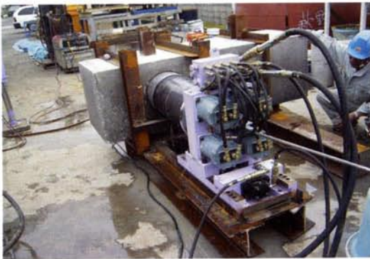
コンクリートブロック 削進状況
