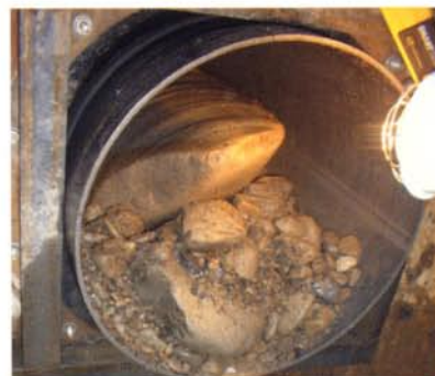
転石削進状況
